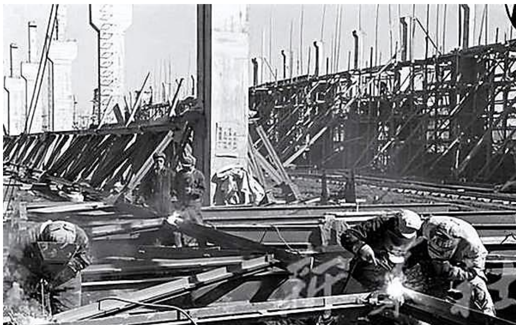
Промышленное строительство в провинции Шэньси, 1954 г.
