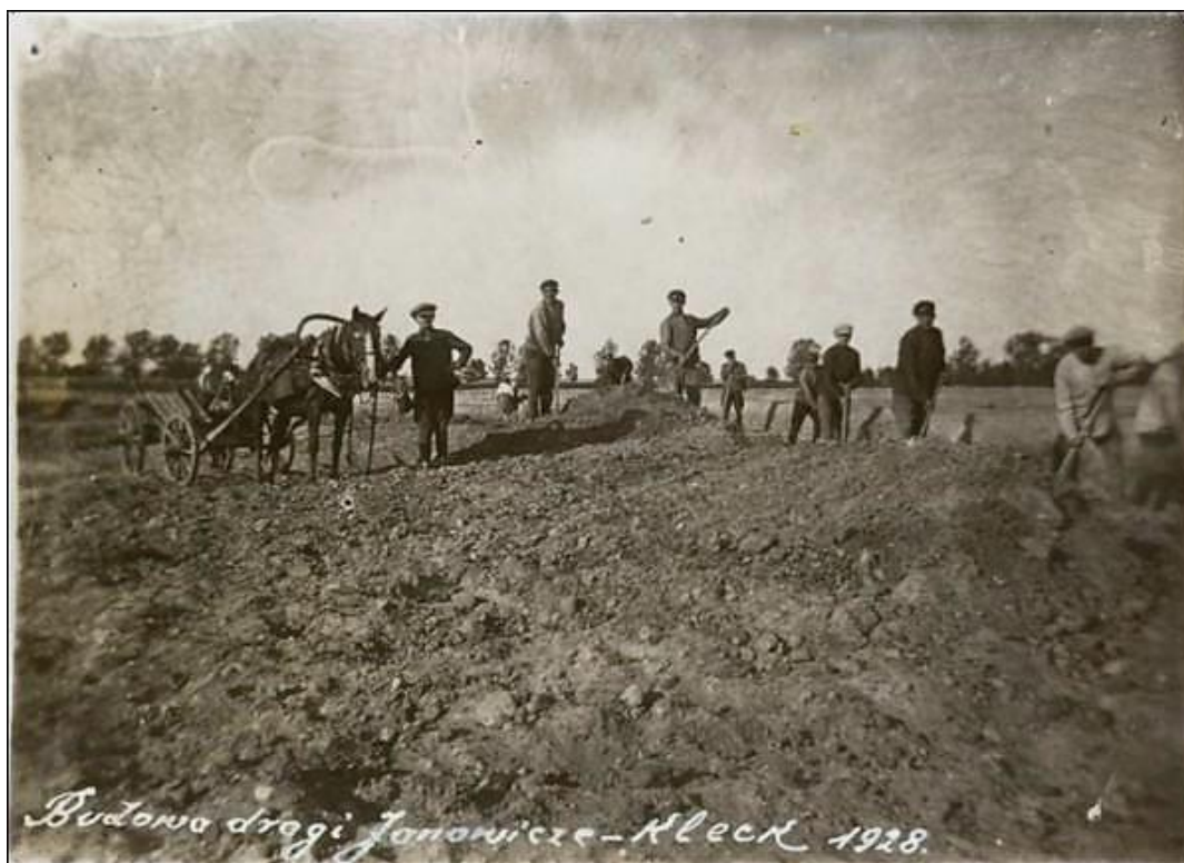
Строительство дороги Клецк–Яновичи, Несвижский повет Новогрудского воеводства, 1928 г.
