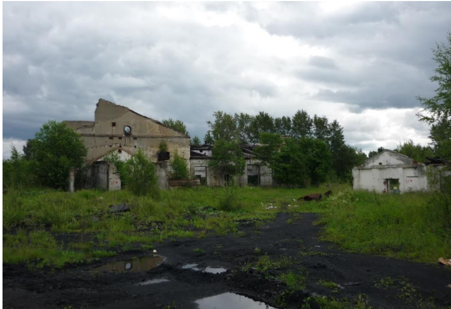
Рис. 5. Разрушенные корпуса Соймоволовской бумажной фабрики (пос. Андогский). Здесь в 1946–1947 гг. работали военнопленные Источник: фото А.Б. Сычева, июль 2008 г.
