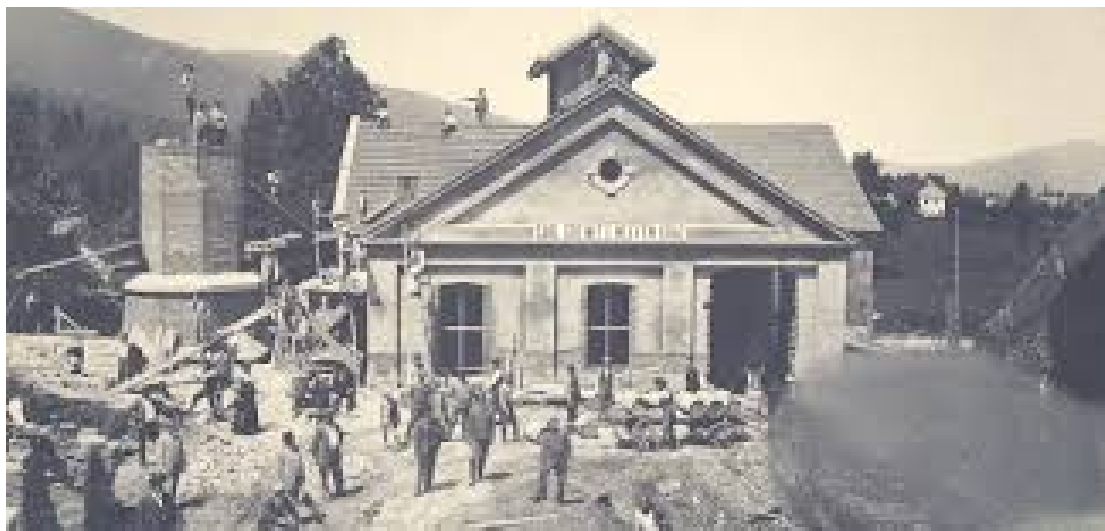
Строительство первой электростанции в Любляне
